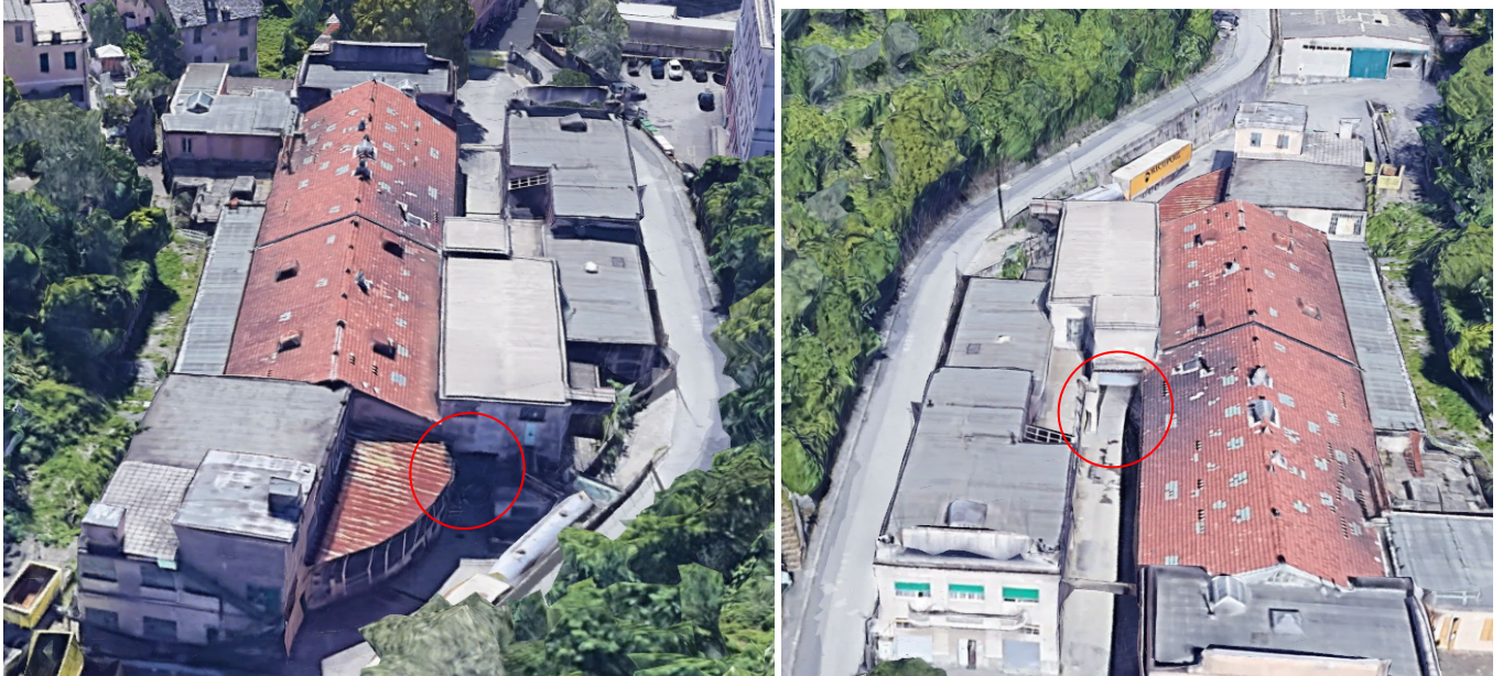
Fig. 39: Apertura presente in un edificio per il transito di mezzi che consente il passaggio dell'acqua e pertanto l'edificio non è stato inserito nel LIDAR-DTM.
